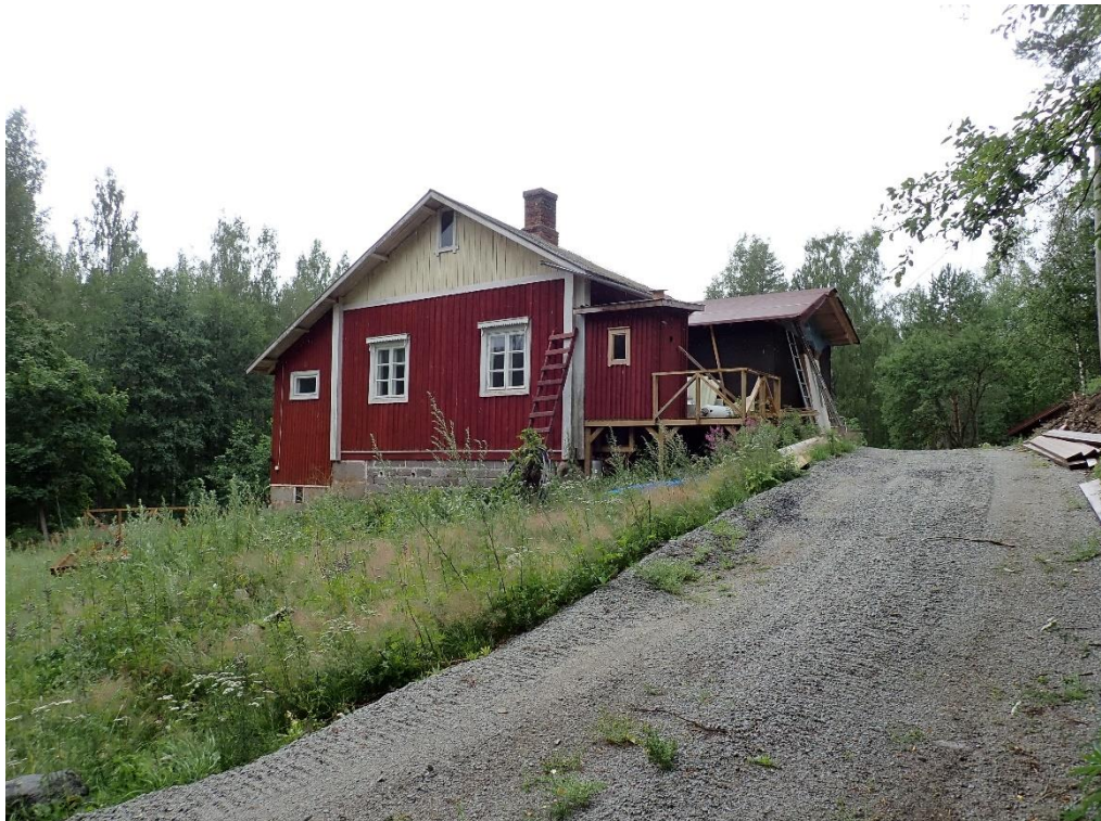
Kuva 1. Kaustaran päärakennus kesällä 2020.
